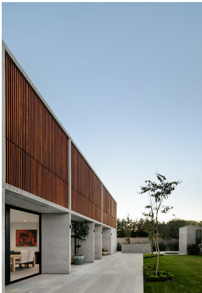
Casa Campanario 420 m2
