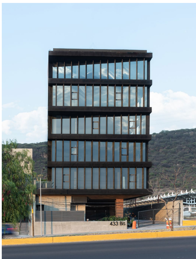
Corporativo E 6,000 m2 Albañilerías
